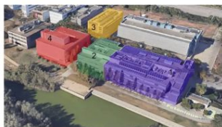
1- ICFO EAST 2- ICFO WEST 3- ICFO BIR PLUS 4- ICFO WEST Dotació de l'ajut: 6.000.000 €
